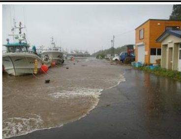
防波堤を越波した波の遡上状況 (鴛泊港)
