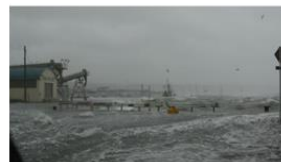
荒天時の岸壁浸水状況(H18.10)
