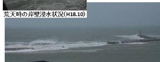
防波堤(南)の越波状況(網走港)
