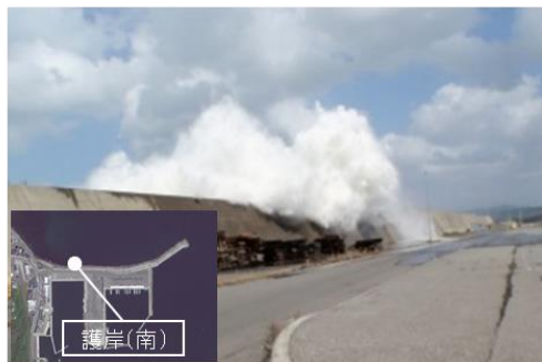
護岸の越波状況(増毛港)
