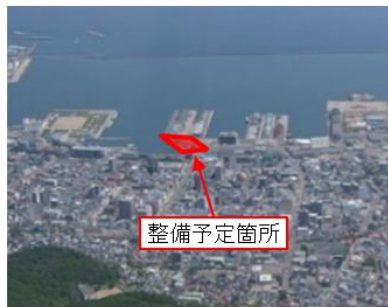
クルーズ受け入れのための第3号埠頭の緑地改良（小樽港 第3号埠頭）
