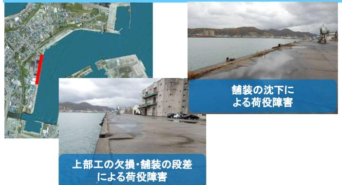
舗装の沈下による荷役障害
