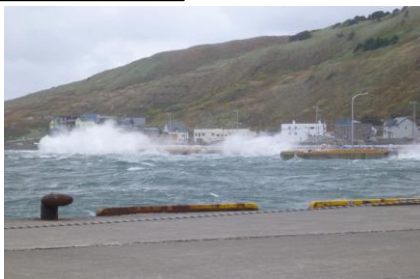
荒天時における港内擾乱 (香深港)
