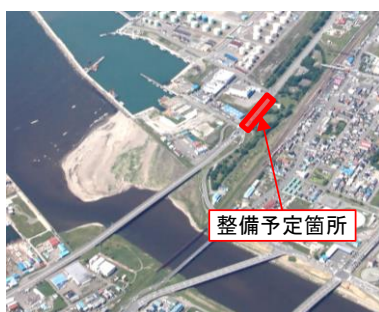
国際物流ターミナル（穀物）に接続する西港道路改修（釧路港 西港区）
