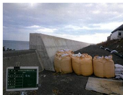
老朽化した護岸の補修・嵩上げ（紋別港海岸）
