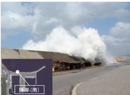
護岸の越波状況(増毛港)
