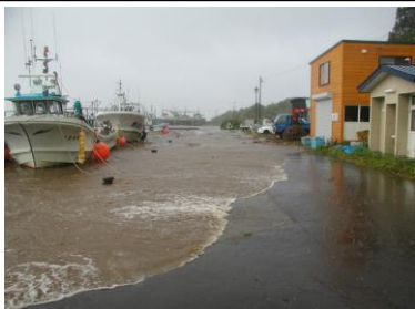
防波堤を越した波の遡上状況 (鴛泊港)
