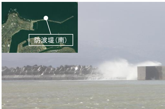
防波堤(南)の越波状況(留萌港)
