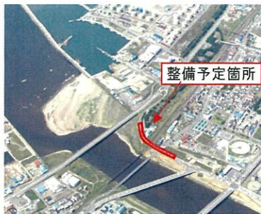
国際物流ターミナル（穀物）に接続する東跨線橋の老朽化対策（釧路港 西港区）
