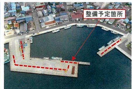
ナマコ漁船が利用する物揚場の防風柵の整備（沓形港）
