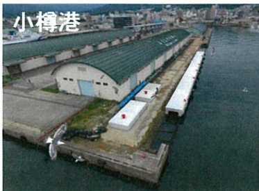
小樽港第3号ふ頭岸壁(-10m)整備状況
