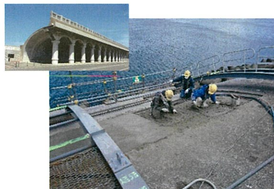
老朽化した北防波堤ドームの修復(稚内港)
