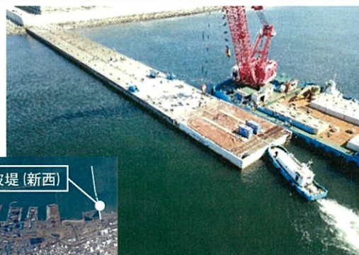
港内静穏度を向上させる防波堤延伸(釧路港)
