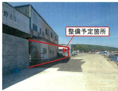
津波・高潮対策のための防潮堤の整備（奥尻港海岸）
