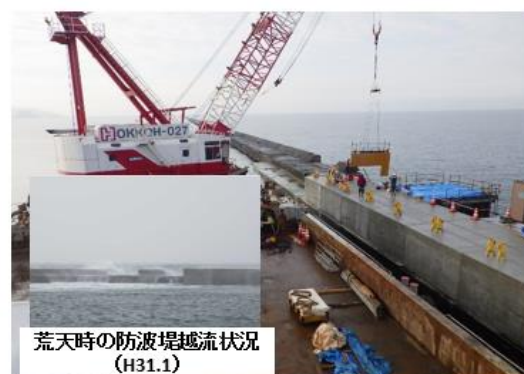
老朽化した防波堤(北外)の補修(室蘭港)
