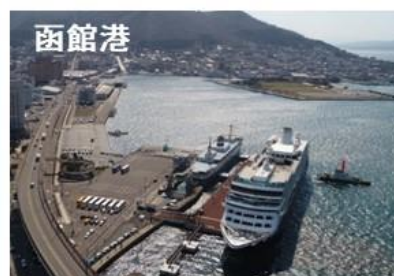
函館港若松ふ頭岸壁(-10m) <暫定-8m>クルーズ船接岸状況
