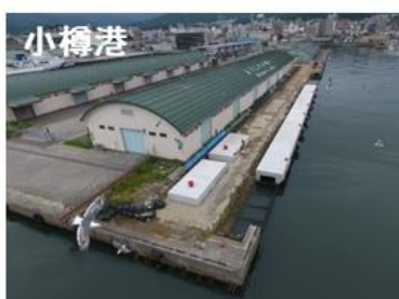
小樽港第3号ふ頭岸壁(-10m)整備状況
