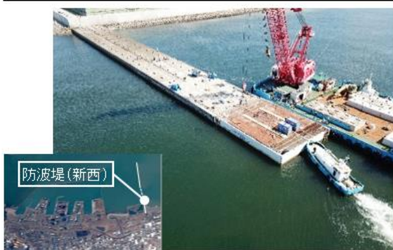
港内静穏度を向上させる防波堤延伸(釧路港)
