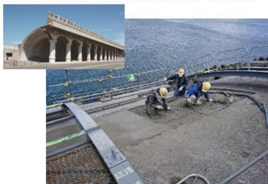
老朽化した北防波堤ドームの修復(稚内港)
